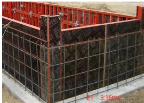
Слика 256. Примена на фурнирски плочи во градежиштвото за оплатирање [28]
