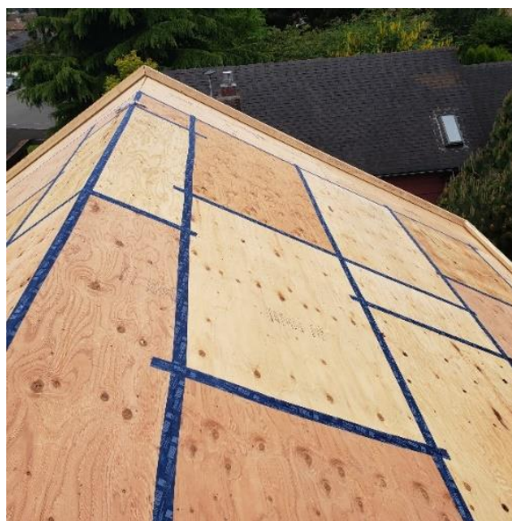
Слика 259. Примена на фурнирски плочи во кровни конструкции на дрвени монтажни објекти [16]
