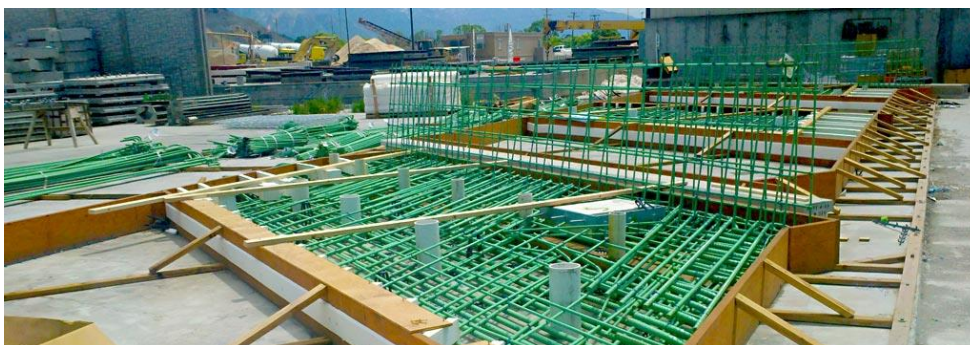
Слика 250. Примена на LVL-плочите во вид на оплата [66]
